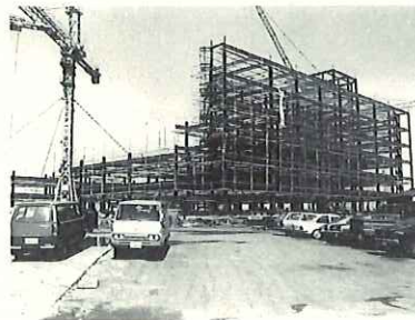
建設中の市役所庁舎 1975(昭和50)年
