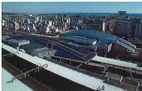
小田原駅東西自由連絡通路アークロード開通 2003(平成15)年
